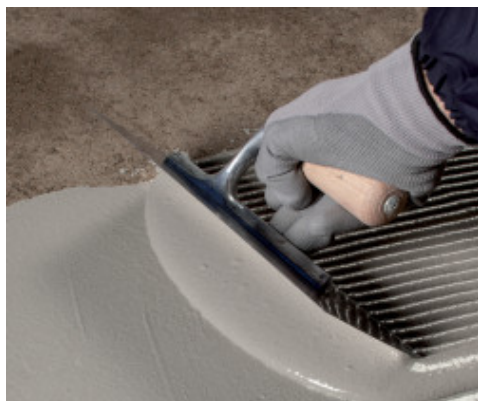
A Mapelastik Turbo első rétegének felhordása
