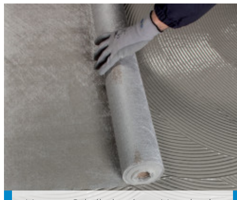
Mapetex Sel elhelyezése a Mapelastik Turbo első rétegébe amíg az még nedves
