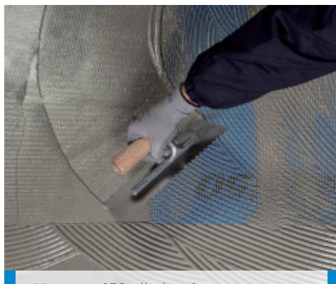
Mapenet 150 elhelyezése a Mapelastik Turbo első rétegébe amíg az még nedves
