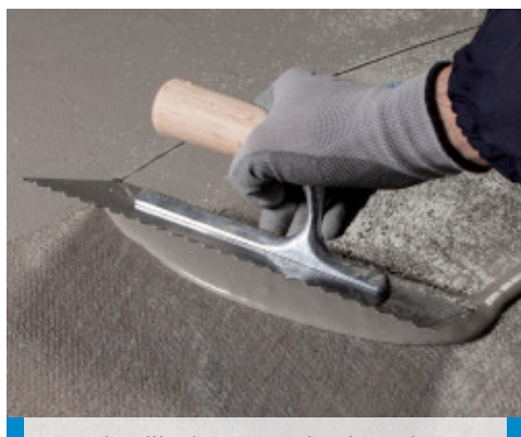
A második réteg Mapelastik Turbo felhordása az első, Mapetex Sel-lel erősített rétegre
