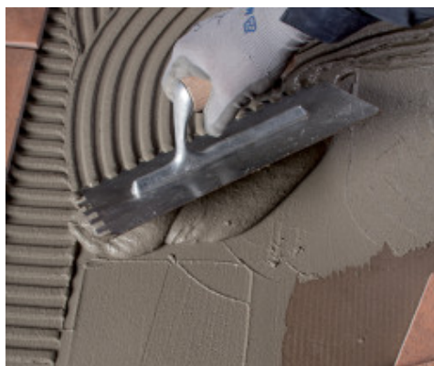
Burkolat ragasztása Elastorapiddal
