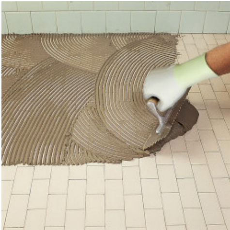
Polírozott márvány burkolólap ragasztása padlóra
