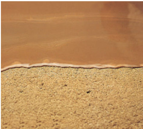
Esztrich gyorsjavítása egy áruházban
