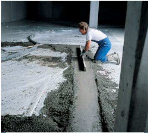
Vezetősáv készítése
