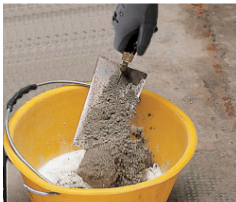
Mapecem bekeverése Planicrete-tel tapadóhid készítéséhez
