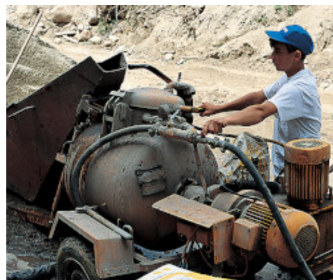
Mapecem bekeverése automata esztrichkevével
