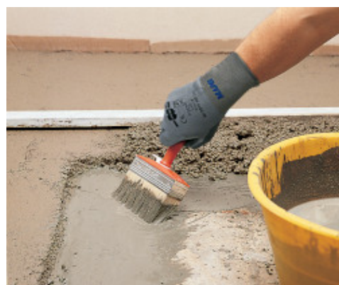
Tapadóhíd felhordása Mapecem-mel készített kötött esztrich alá
