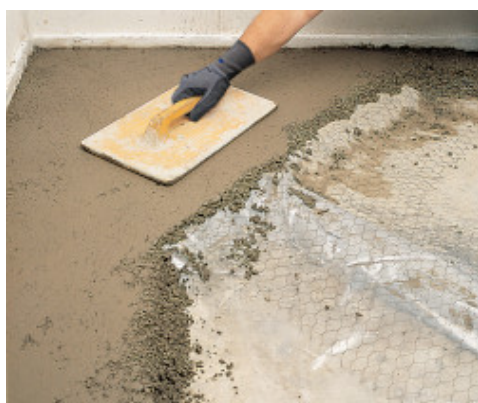
Csőek fedése Mapecem-mel és erősítőháló fektetése
