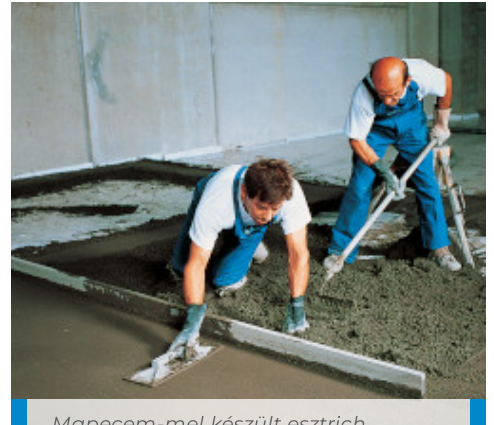
Mapecem-mel készült esztrich tömörítése
