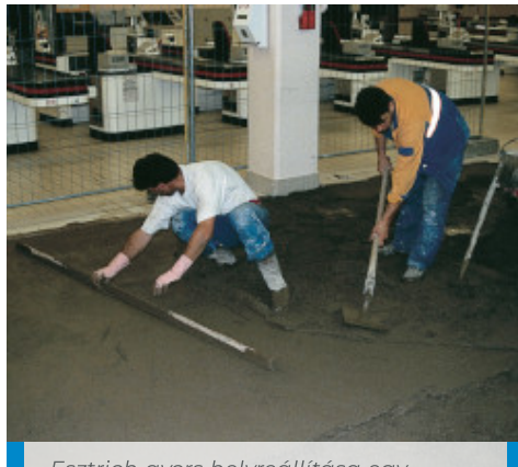
Esztrich gyors helyreállítása egy bevásárlóközpontban
