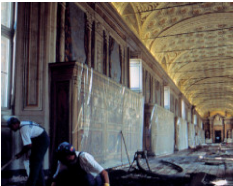
Mapecem esztrich fektetése és simítása - Szixtuszi Előcsarnokok - Vatikánváros
