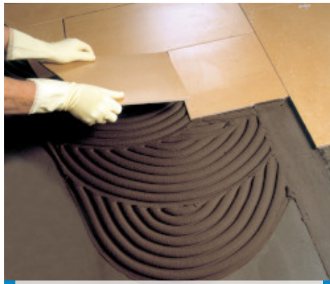
Porcelán burkolólapok fektetése Mapelastic-kal vízszigetelt esztrichre
