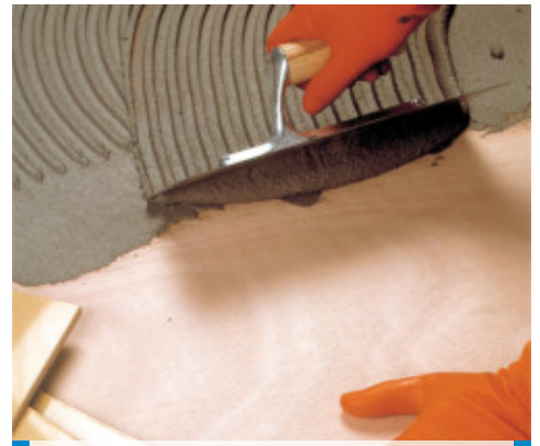
Porcelán burkolólapok ragasztása Elastorapid-dal rétegelt lemezre
