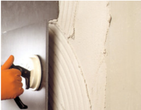
Nagyméretű kőporcelán burkolólapok ragasztása Elastorapid-dal beton homlokzatra
