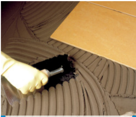
Elastorapid feldolgozása fogazott simítóval cementkötésű esztrichre
