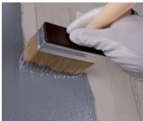
Eco Prim Grip Plus felhordása betonra ecsettel
