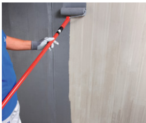
Eco Prim Grip Plus felhordása betonra hengerrel
