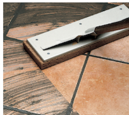
Egyszer-égetett kerámia burkolatú padló tisztítása nyeles tisztítószivaccsal
