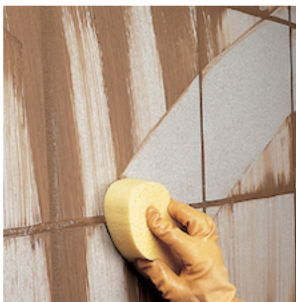
Falburkolat tisztítása tisztítószivaccsal
