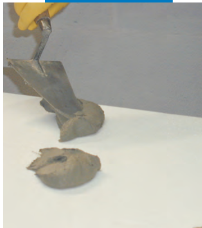
Mapetherm AR1 felhordása a tábla hátoldalára pontokban vakolókánállal
