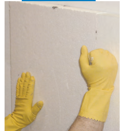
A felhelyezett táblát erősen nyomja. Ezzel lehet biztosítani a jó tapadást a felületre
