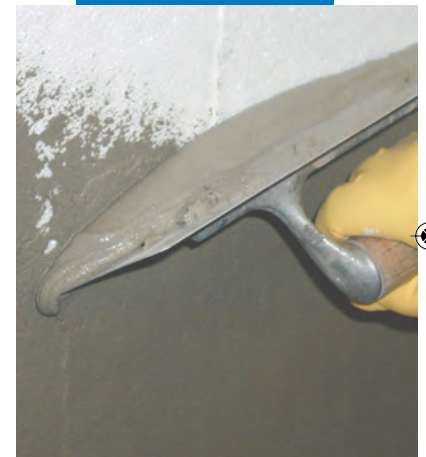
Hőszigetelő táblák simítása: Mapetherm AR1 terítése
