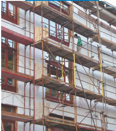
Szigetelőtáblák ragasztása homlokzatra Mapetherm AR1-gyel
