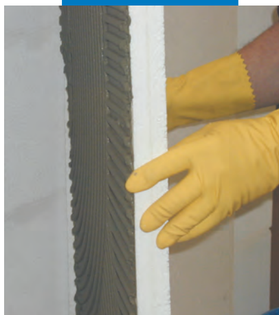
Hőszigetelő panel felhelyezése
