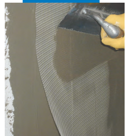
Mapetherm AR1 rétegbe fektetett Üvegszövet Hálóval erősített hőszigetelő táblák simítása
