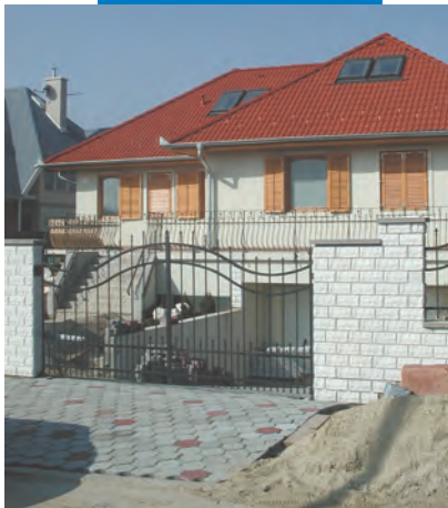
Habosított hőszigeteléssel készült családi ház - Magyarország
