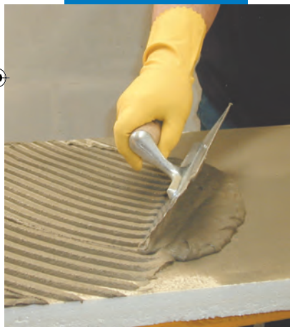
Mapetherm AR1 felhordása a tábla hátoldalára fogazott simítóval
