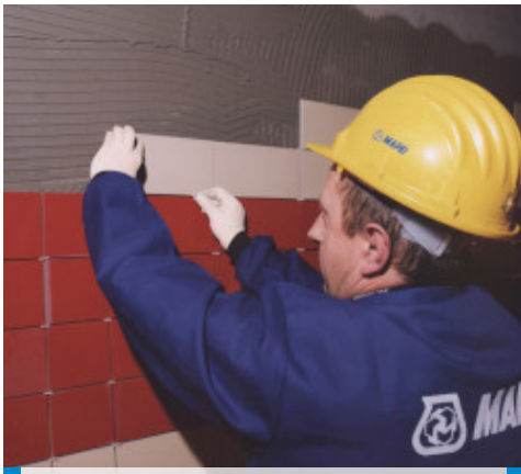
Kerámia burkolólap ragasztása falra
