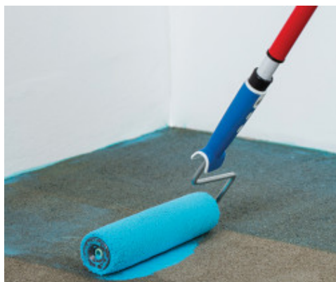
A Mapeproof Primer első rétegének felhordása
