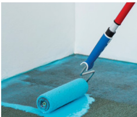
A Mapeproof Primer második rétegének felhordása
