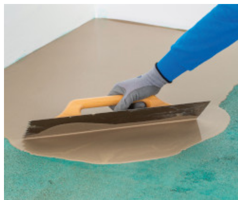
Önterülő aljzatkiegyenlítő felhordása a Mapeproof Primer-re
