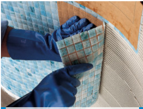
2x2 cm-es üvegmozaik ragasztása úszómedencében vízzel 1:1 arányban hígított Isolastic Adesilex P10 keverékével
