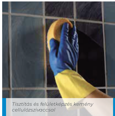
Kerapoxy CQ felület megnedvesítése, és Scotch-Brite® súrolószivacsos emulgeálás
