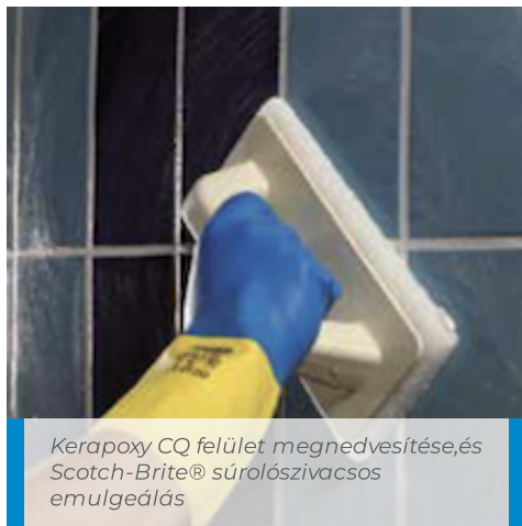
Tisztítás és felületképzés kemény cellulózszivaccsal
