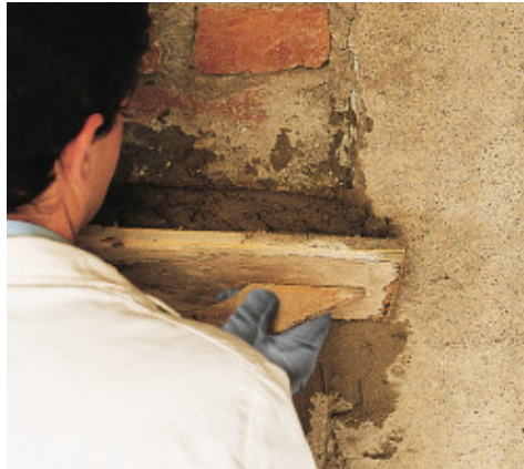
Régi téglafalazat helyreállítása
