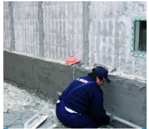
A vakolat lehúzása vakolóléccel
