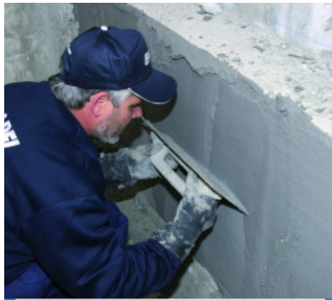
A Nivoplan bedolgozása simítóval
