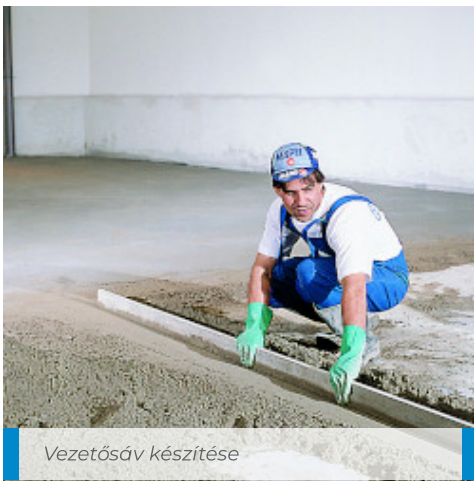
Topcem esztrich bedolgozása
