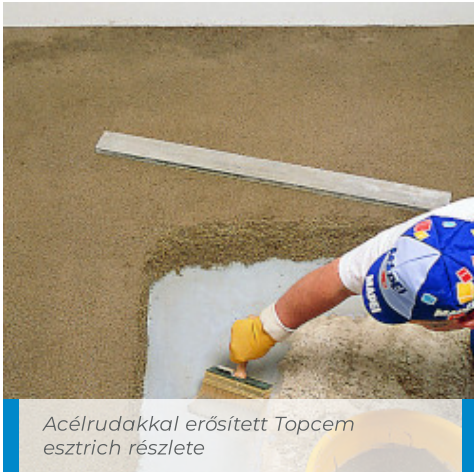
Vezetősáv készítése
